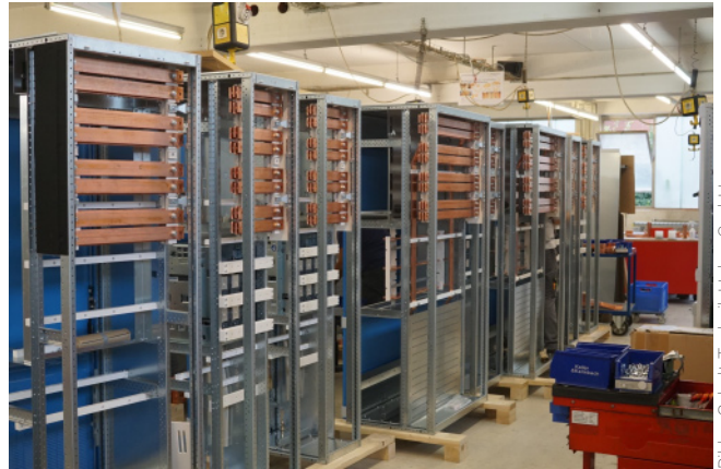
Bild 3 | ... um dann passgenau montiert zu werden.
